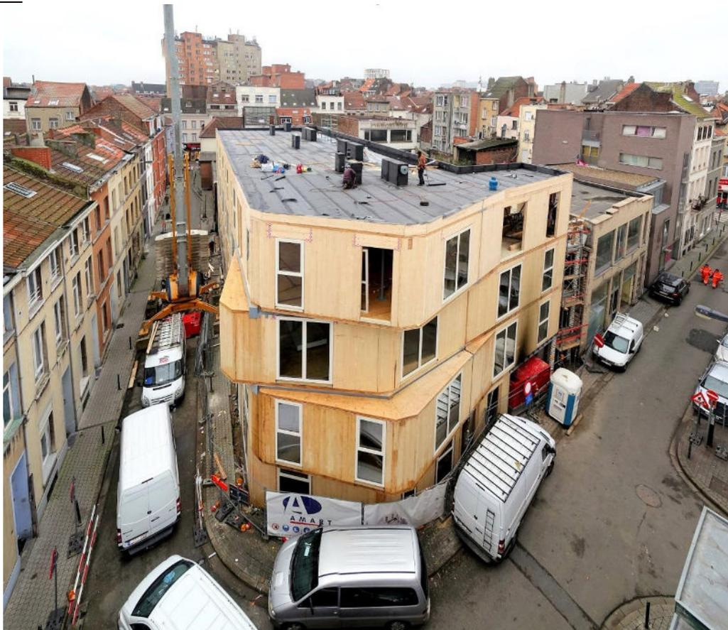
Le chantier Perle (construction neuve passive de 17 logements) à Molenbeek a démarré en août 2017. Nous avons choisi de travailler avec l'entreprise Amart associée à l'entreprise Lamcol pour le gros œuvre. En effet, ce bâtiment de 4 niveaux est en structure bois. Le chantier devrait durer 12 mois. La construction est spectaculaire puisque le gros œuvre a été construit en seulement quelques semaines. Les panneaux en lamellé collés sont préfabriqués et assemblés sur chantier.
