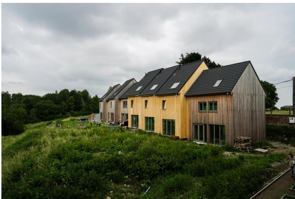
La phase 2 de construction de 4 maisons en ossature bois remplissage paille avance bien. Fin 2017, le gros œuvre fermé étanche des 4 maisons était finalisé.
